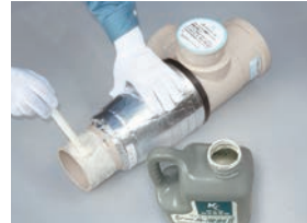
上階の集合管の差し口にマーキング(挿入深さ75mm)を施し、シール滑剤を塗布します。
