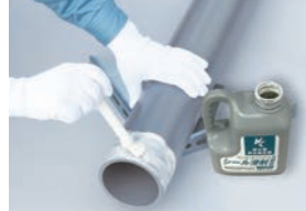
差し口側にマーキング(挿入深さ70mm)を施し、シール滑剤を塗布します。
