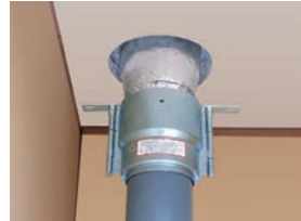
上階より集合管を挿入します。
