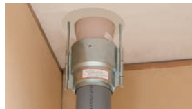
スリーブをモルタルで埋め戻します。全ねじボルトの先端も一緒に埋め込み(40mm以上)、固定します。
