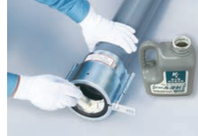
立て管受け口のゴムリングに、シール滑剤を塗布します。
