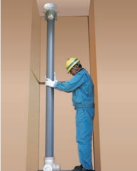
上階の集合管の差し口にマーキング(挿入深さ75mm)を施し、シール滑剤を塗布します。
