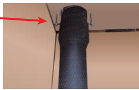
上階の集合管の差し口にマーキング(挿入深さ75mm)を施し、シール滑剤を塗布します。
