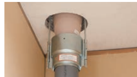
上階より集合管を挿入します。
