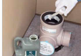
集合管の立て管受け口のゴムリングにシール滑剤を塗布し、カンベイ立て管を挿入します。
