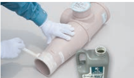
上階の集合管の差し口にマーキング(挿入深さ75mm)を施し、シール滑剤を塗布します。
