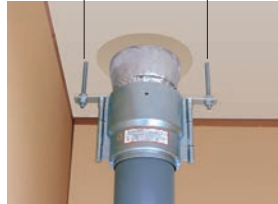
スリーブをモルタルで埋め戻し、支持金具を床スラブから吊り下げます。
