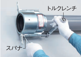
高ナット側をスパナ等で固定し、六角ボルトの頭側をトルクレンチ等で締め付けます。(二面幅13mm)
