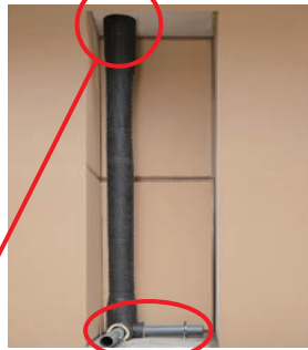
スリーブをモルタルで埋め戻します。全ねじボルトの先端も一緒に埋め込み(40mm以上)、固定します。
