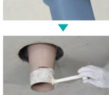
天井側の既設集合管下部の差し口部分に挿入深さをマーキングし、滑剤(クボタケミックス純正シール滑剤II)を塗布します。
