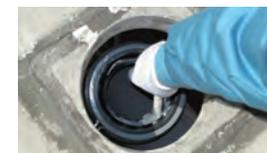
6 4SR形集合管の差し口をコンパクトLベンドの立て管受け口に挿入し、接合します。接合後、挿入深さをマーキング位置で確認してください。
