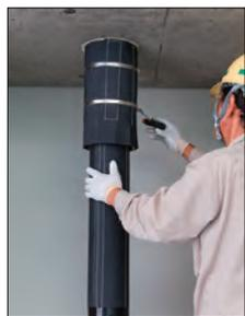
製品と同梱の固定バンドを、集合管の上と延焼防止部材の上の2箇所に巻き付け、クボタイカバーがずり落ちないように固定します。クボタイカバー上端とスラブとの隙間ができないよう注意してください。
