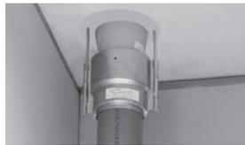
スリーブをモルタルで埋め戻します。全ねじボルトの先端も一緒に埋め込み(40mm以上)、固定します。
