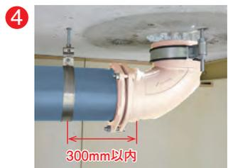
4 横主管を接続し、支持金具で固定します。
