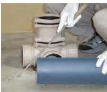
立て管(カンペイ立て管)を適切な長さで切断し、下端部を面取りします。必ず内外面とも面取りを行って、バリ・カエリ等を完全に除去してください。
