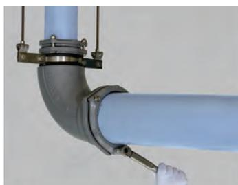
ボルト・ナットを締め付けます。片締めにならないよう、均等に締め付けてください。
