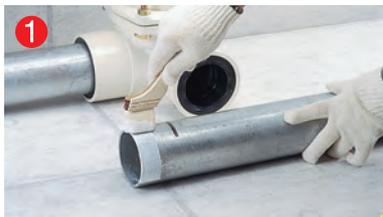
1 挿入する管の外面と端面の全周にクボタケミックス純正シーリング剤IIを塗布します。
