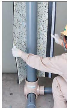
再生ウレタンが内側になるように立て管にセットします。カンペイシートの下端は、集合管受け口の上端に合わせます。
