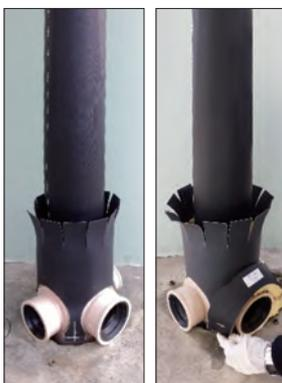
②枝部クボタイカバーの製品情報シールを枝管受け口の上面側、耳の部分に集合管側とし、グラスウールが内側になるよう枝管受け口にセットします。枝部クボタイカバー(50~75枝用)については、呼び径65の場合は両端を20mmずつ、呼び径50の場合は両端を40mmずつカットしてから使用します。(枝管受け口下面をカバーしない場合は、施工状態に合わせて、さらにカットします)
