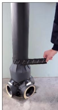
③遮音シート専用固定テープ(別売)を用いて、上部クボタイカバーに枝部クボタイカバーを固定します。固定テープの長さは、枝部クボタイカバー 1個に対し、60cmを目安としてください。集合管と直管の段差部分は、遮音シートの切込みを利用して径を絞り、固定テープで固定します。固定テープの長さは、60cm×2巻きを目安としてください。
