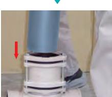
立て管をQMユニオン継手に鉛直に挿入し、更新対応集合管の接合部上端と突き合わせます。
