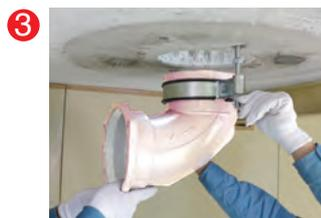
3 支持金具の両端のボルト通し穴に、スラブに固定した全ねじボルトを通し、ベンド本体を吊り下げます。
