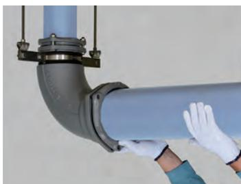
管の差し口がベンドの受け口の最奥部に突き当たるまで挿入します。
