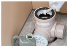
集合管の立て管受け口のゴムリングにシール滑剤を塗布し、カンペイ立て管を挿入します。
