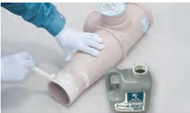
上階の集合管の差し口にマーキング(挿入深さ75mm)を施し、シール滑剤を塗布します。
