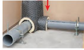
カンペイ立管と集合管に、グラスウールと遮音シートを巻き、亀甲金網(線径0.4mm以上)で固定します。
