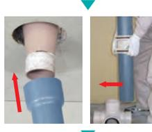
新しい立て管のカンペイ立て管受け口を上階の集合管下部に挿入し、立て管下端を床上の集合管上部の接合部に突き合わせます。
