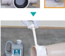
上階に設置する集合管下部の差し口部分に挿入深さをマーキングし、シール滑剤を塗布します。
