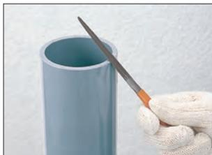
●挿入パイプの端部を面取りします。
