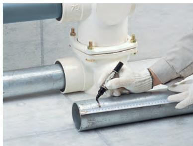
管の差し口外面や集合管受け口のゴム輪に砂や泥が付着していれば除去します。次に、差し口の外面に挿入深さをマーキングします。
