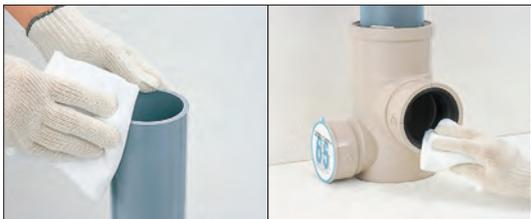
●挿入パイプ外面とゴム輪内面の付着物等の異物を拭き取ります。
