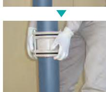
更新対応集合管の上部接合部をかわすように立て管の下端を横方向にずらします。
