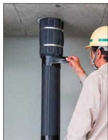
集合管と直管の段差部分は、遮音シートの切込みを利用して径を絞り、遮音シート専用固定テープ(別売)を巻き付けて固定します。固定テープの長さは、60cm×2巻きを目安としてください。
