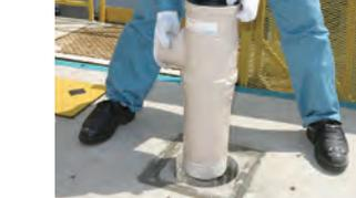
5 4SR形集合管の差し口に、挿入深さ(=75mm)をマーキングします。集合管の差し口と、コンパクトLベンドの立て管受け口ワンタッチゴム輪に、クボタケミックス純正シーリング剤IIを塗布します。
