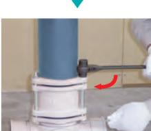
QMユニオン継手上部のナットを締め付けます。
