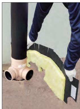
①遮音シートの切込み側を上にして、グラスウールが内側になるよう集合管上部にセットします。上部クボタイカバーの穴に集合管の枝管受け口を通し、下端はスラブ上面に合わせます。重ね合わせ部分がシワにならないよう注意しながら、面ファスナーのオス・メスを重ね合わせて巻き付けます。この際、上部クボタイカバーの下端が、下部の遮音材と重ならないように巻き付けてください。
