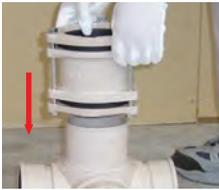
更新対応集合管上部の接合部にQMユニオン継手を挿入します。この時、QMユニオン継手のナットが上になるようにセットしてください。
