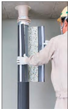
立て管の長さに合わせて、カンペイシートをハサミで切断します。カンペイ君の下端とカンペイシートの上端を合わせて巻き付けます。
