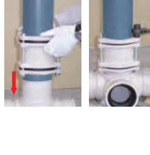
QMユニオン継手のナットを一旦緩め、ボルトの頭が集合管肩面に接地するまで引き下ろします。
