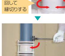
QMユニオン継手を適当な高さまで引き上げ、上部のナットを締め付けて仮固定します。
