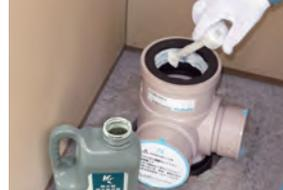
集合管の立て管受け口のゴムリングにシール滑剤を塗布し、カンペイ立管を挿入します。
