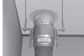
スリーブをモルタルで埋め戻し、支持金具を床スラブから吊り下げます。
