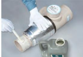
上階の集合管の差し口にマーキング(挿入深さ75mm)を施し、シール滑剤を塗布します。
