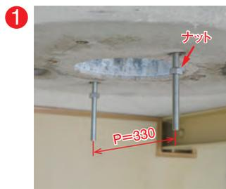
1 スラブ貫通部の両脇に、支持金具を吊り下げのための全ねじボルト(W1/2またはW5/8)を設置します。全ねじボルトには、六角ナットを予めつけておきます。
