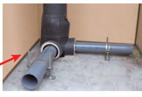
カンペイ立管と集合管にグラスウール・遮音シートを巻き、亀甲金網(線径0.4mm以上)で固定します。
