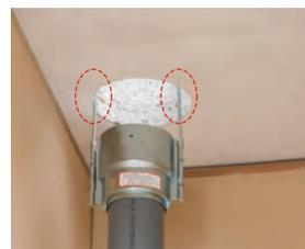
立て管の金物側を上階のスリーブに入れてから、集合管に挿入します。全ねじボルトはスリーブに入った状態(40mm以上)となります。
