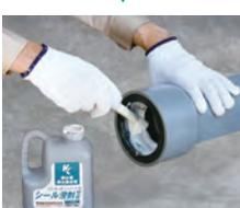
カンペイ立て管の受け口のゴム輪内面に滑剤を塗布します。滑剤には必ずクボタケミックス純正シール滑剤IIをご使用ください。
