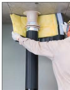
遮音シートの切込み側を下にして、グラスウールが内側になるよう集合管下部にセットします。クボタイカバーの上端はスラブ下面に合わせます。
