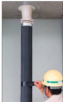
上下のカンペイシートの突き合わせ部の全周に渡り、遮音シート専用固定テープ(別売)を巻き付け固定します。固定テープの長さは、60cm×1巻きを目安としてください。
